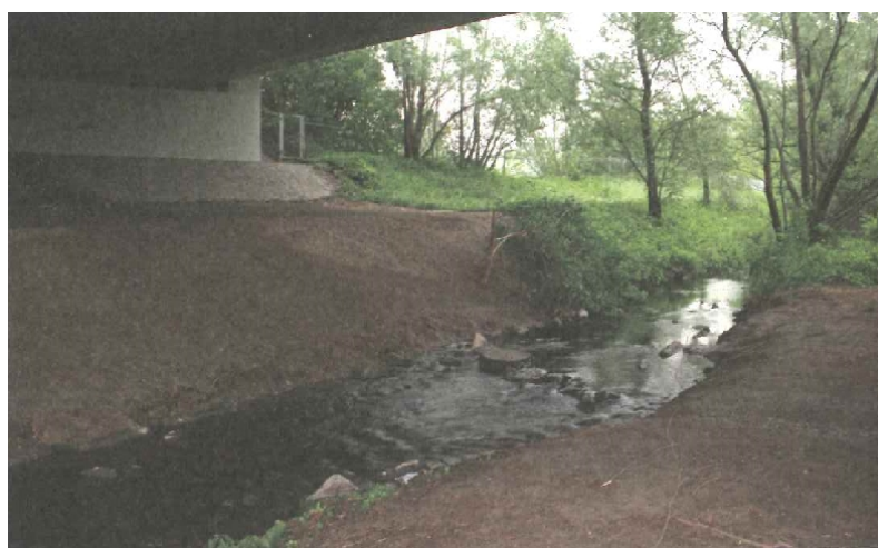
Fot. 6. Przykład naturalnie ukształtowanych skarp otwartego koryta rzecznego biegnącego pod układem drogowym (za: Poradnik projektowania przejść dla zwierząt(...), R.T. Kurek)
