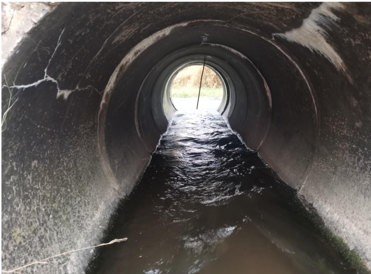
Rys. 3.1 Widok na nieszczelność pomiędzy segmentami oraz przecieki
