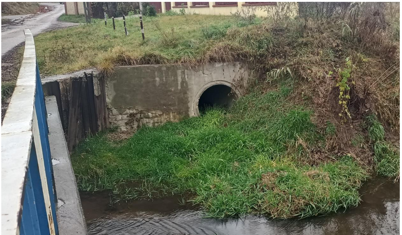
Rys. 3.10 Widok uszkodzonej ściany czołowej istniejącego przepustu
