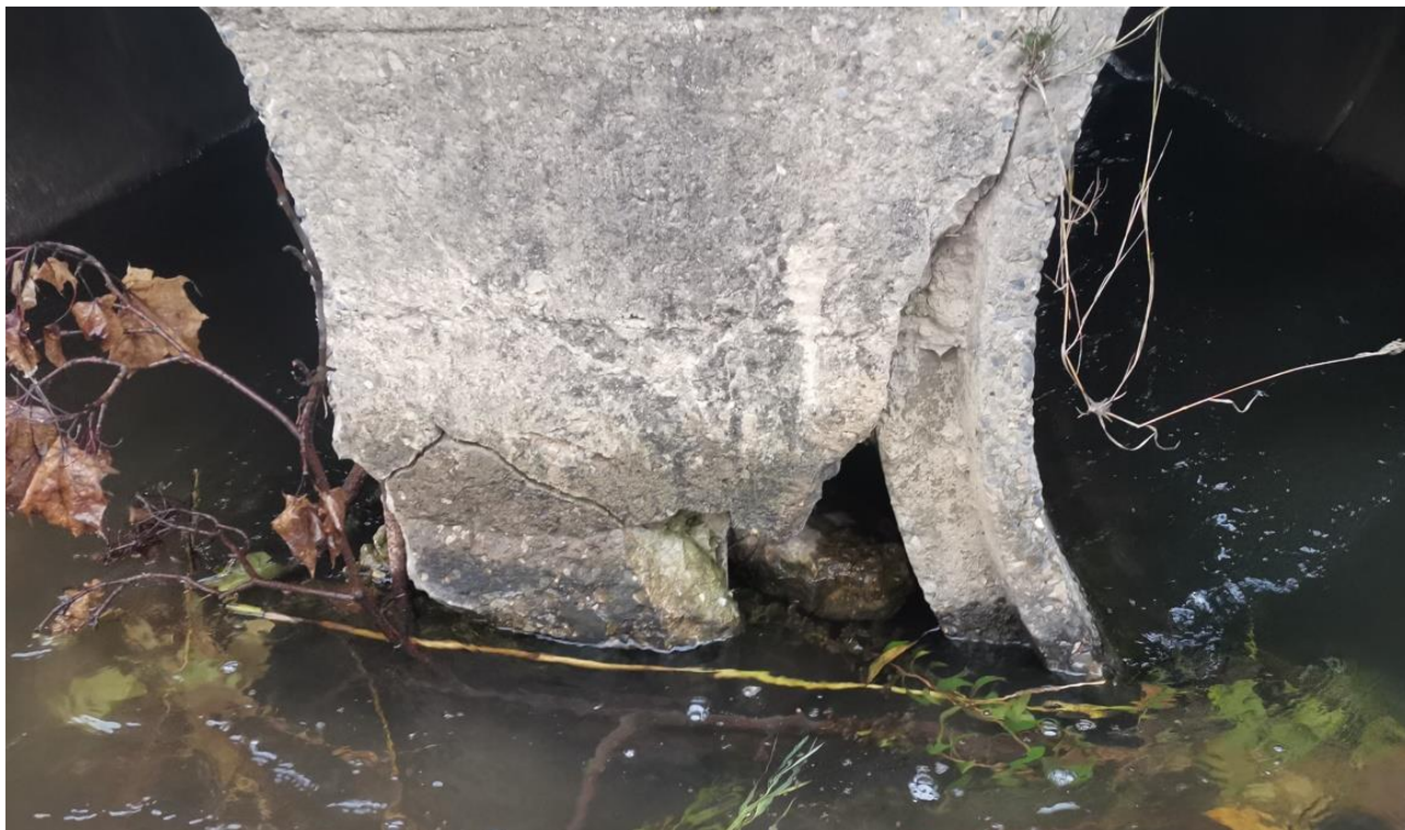
Rys. 3.4 Widoczne spękania i ubytki materiału
