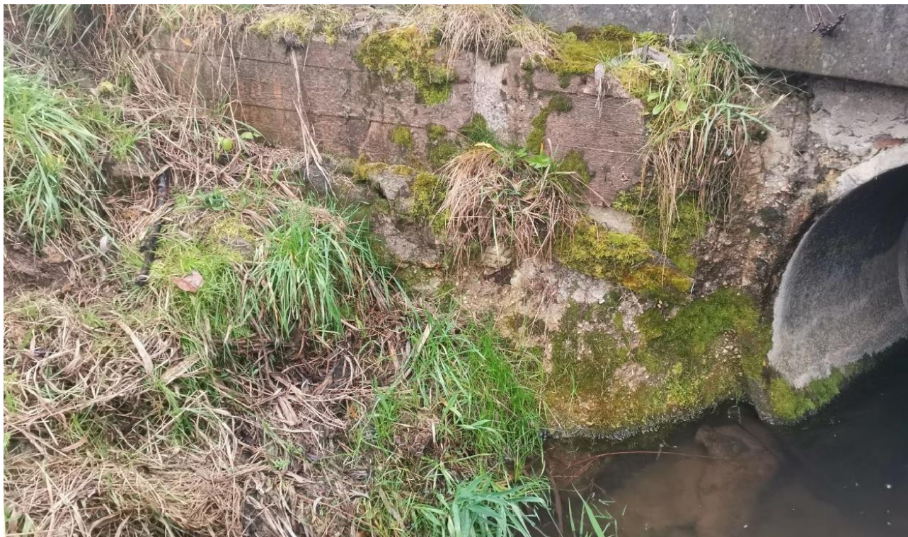
Rys. 3.7 Korozja biologiczna
