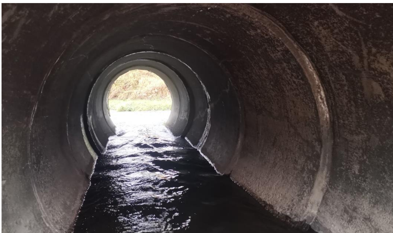
Rys. 3.2 Widok na nieszczelność pomiędzy segmentami
