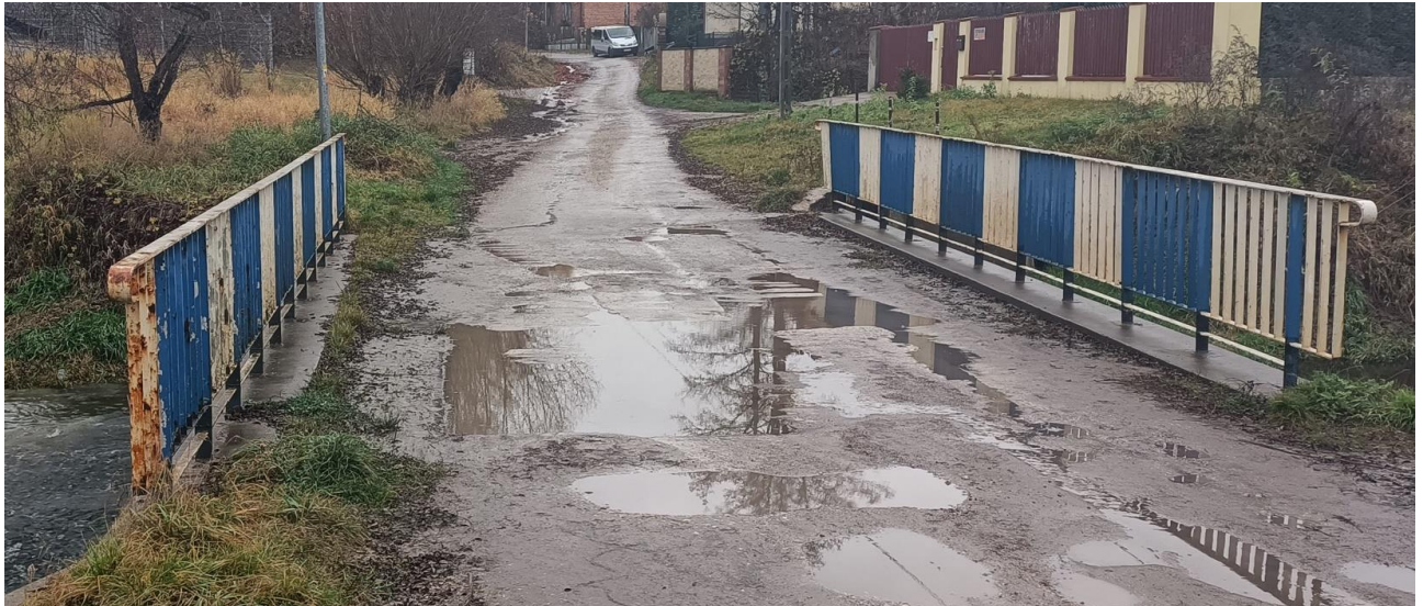
Rys. 3.9 Brak spadków jezdni na obiekcie, skorodowana balustrada, wykwyty przy ścianie czołowej
