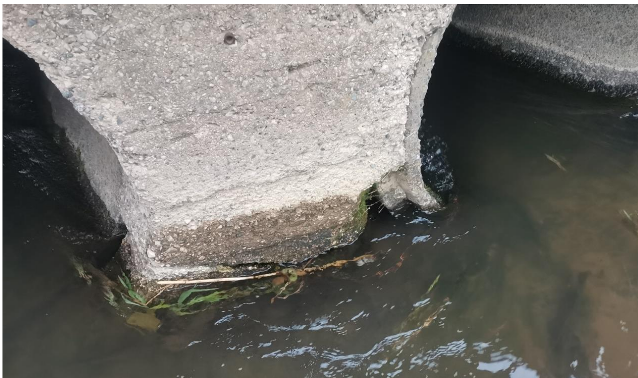
Rys. 3.3 Widoczne ubytki materiału
