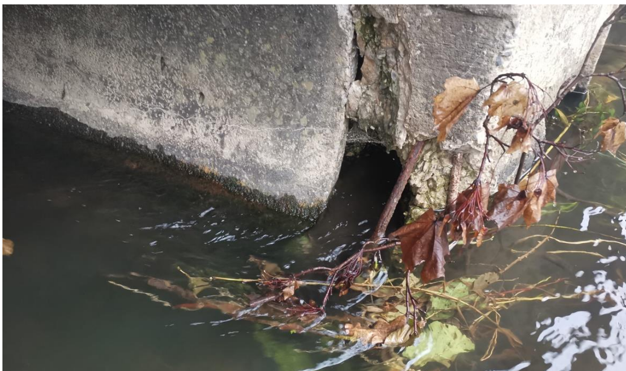
Rys. 3.5 Widoczne spękania, ubytki materiału oraz korozja stali zbrojeniowej
