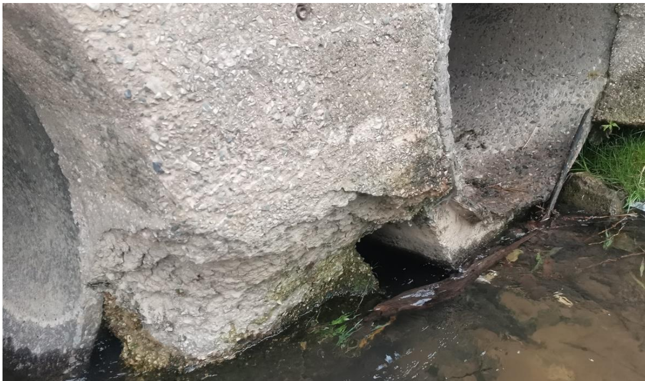
Rys. 3.2 Widoczne ubytki materiału
