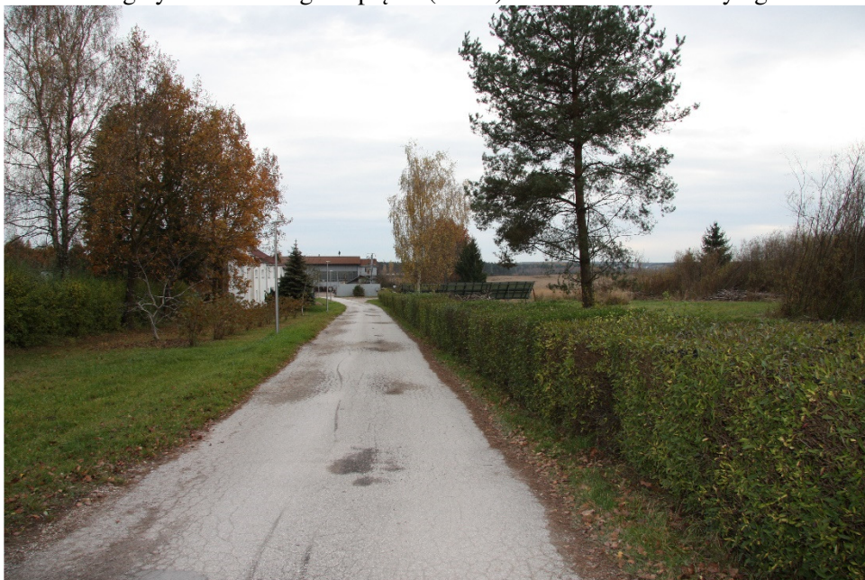
Fot. 6 Widok na odlewnie żeliwa w środkowej części strefy C KOChK.
