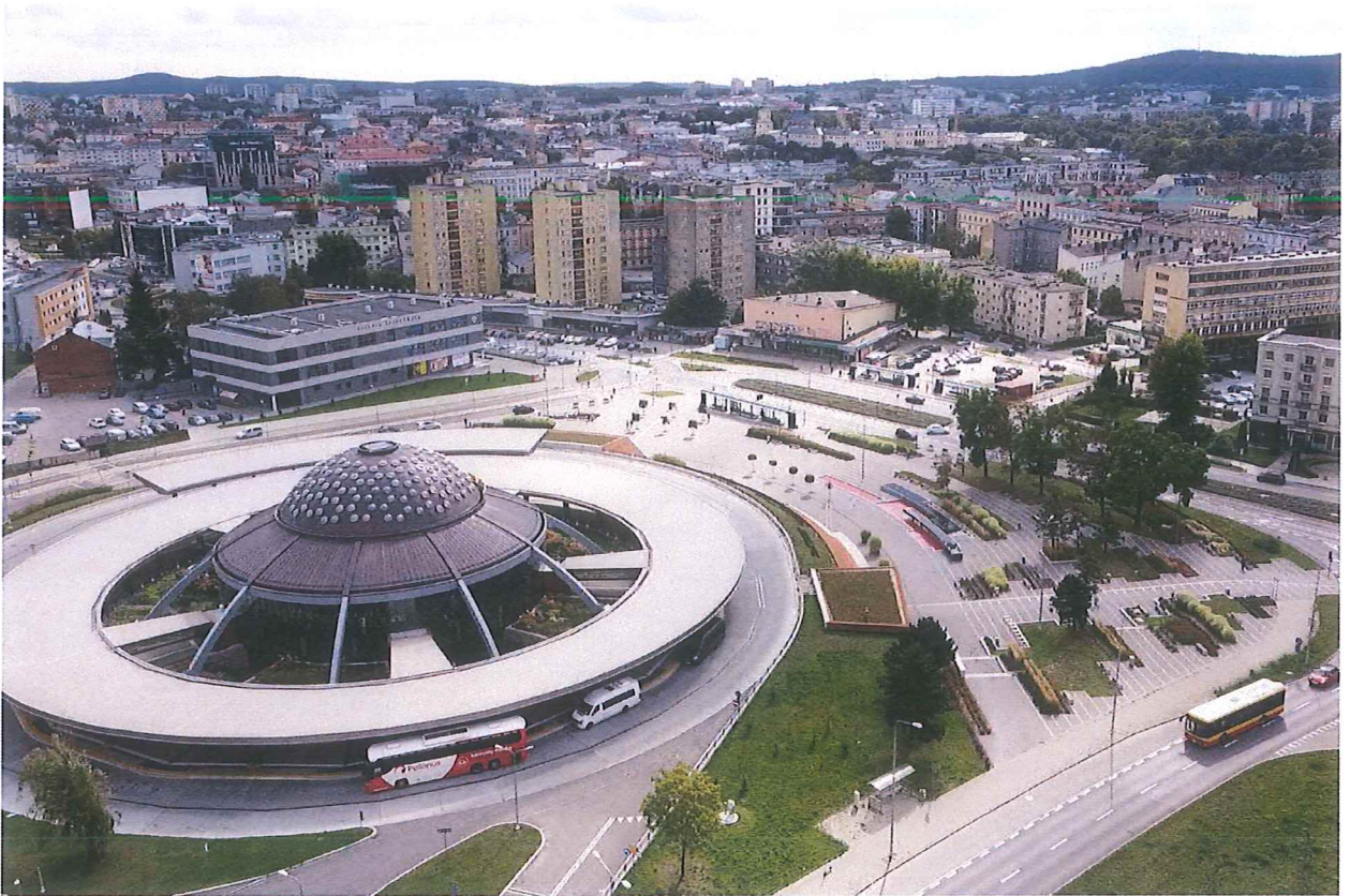
widok od strony północnej
