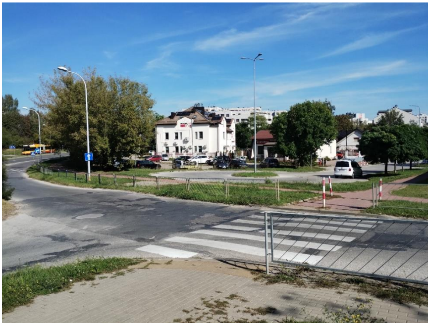
Zdjęcie 2 – w obrębie ul. Chęcińskiej, po stronie wiaduktu
