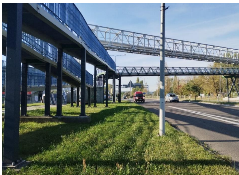
Zdjęcie 1 - kładka dla pieszych
