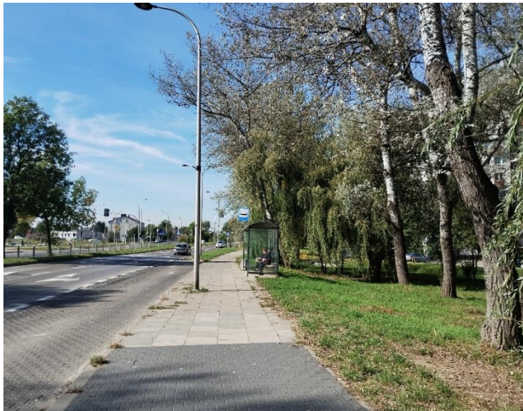
Zdjęcie 1 – w obrębie zatoki autobusowej
